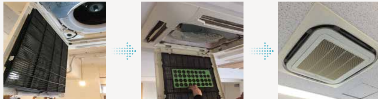
＜設置はとても簡単。エアコンの吸込口フィルターの上に置くだけ＞ (吸込み防止網がない場合はダブルクリップや結束バンドなどでフィルターに固定してください)
